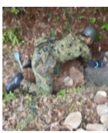
割栗石積み上げ作業中の進藤士長
